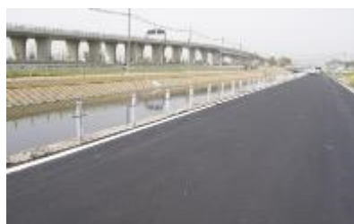
ブラケットの取付完了
