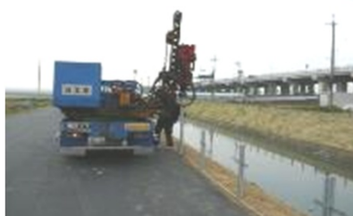
打込み機による内蔵鋼材建柱
