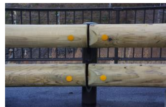
(ウッドレールGへの取付)
